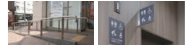
段差のない出入口(スロープ)
