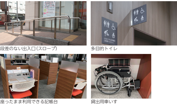
段差のない出入口（スロープ）
